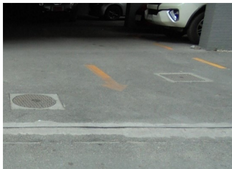
ภาพที่ 4-5 ฝาถังตกตะกอนและบ่อบำบัดน้ำทิ้งก่อนปล่อยออกสู่ท่อระบายสาธารณะ
